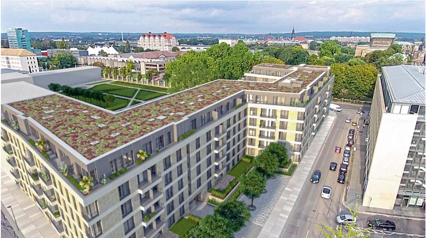
So wird es aussehen, wenn die „Residenz am Zwinger“ fertig ist. – Foto unten: Als riesige Baugrube zeigte sich der Standort im November. Jetzt gibt es dort bereits zwei Geschosse unter der Erde.
