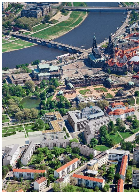
Als wäre das Haus schon immer da gewesen – die neuen Wohnungen ins Stadtbild eingefügt.
