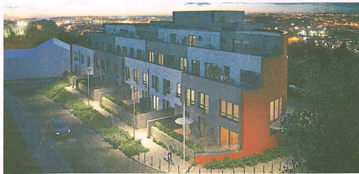
Panorama Pražáčka Projekt, jehož výstavba byla zahájena na začátku letošního srpna, nabídne celkem 26 bytů. Dům je navíc umístěn v koncové, neprůjezdné lokalitě, kam zajíždějí jen rezidenti. Vizualizace: CTR Group
